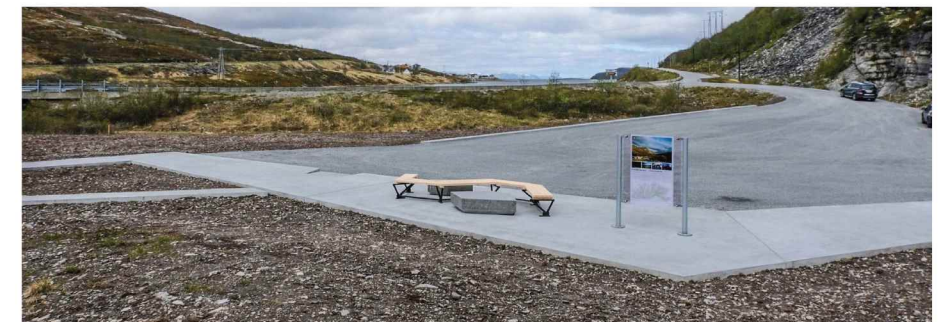
Overgang mellom asfalt grus og betong
