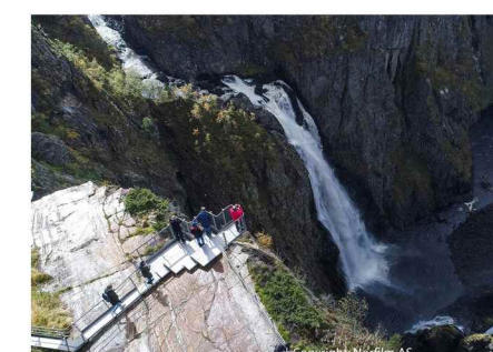
Nivåer i trappeforløpet tilpasses underlaget
