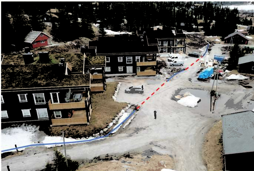
Figur 7: Oversiktsfoto bekkeomlegging ved befaringstidspunkt
