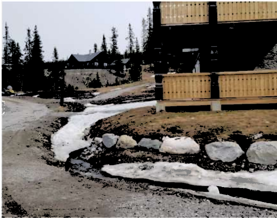
Figur 8: Utførelse av bekkeomlegging, øvre del
