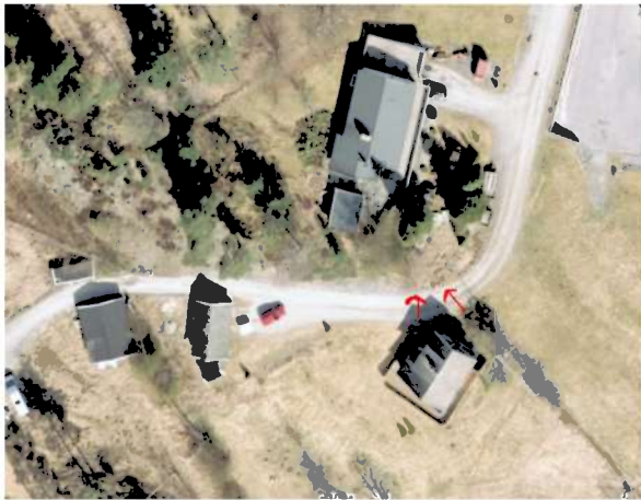
Figur 3-14 Dagens situasjon med veg tett på hus
