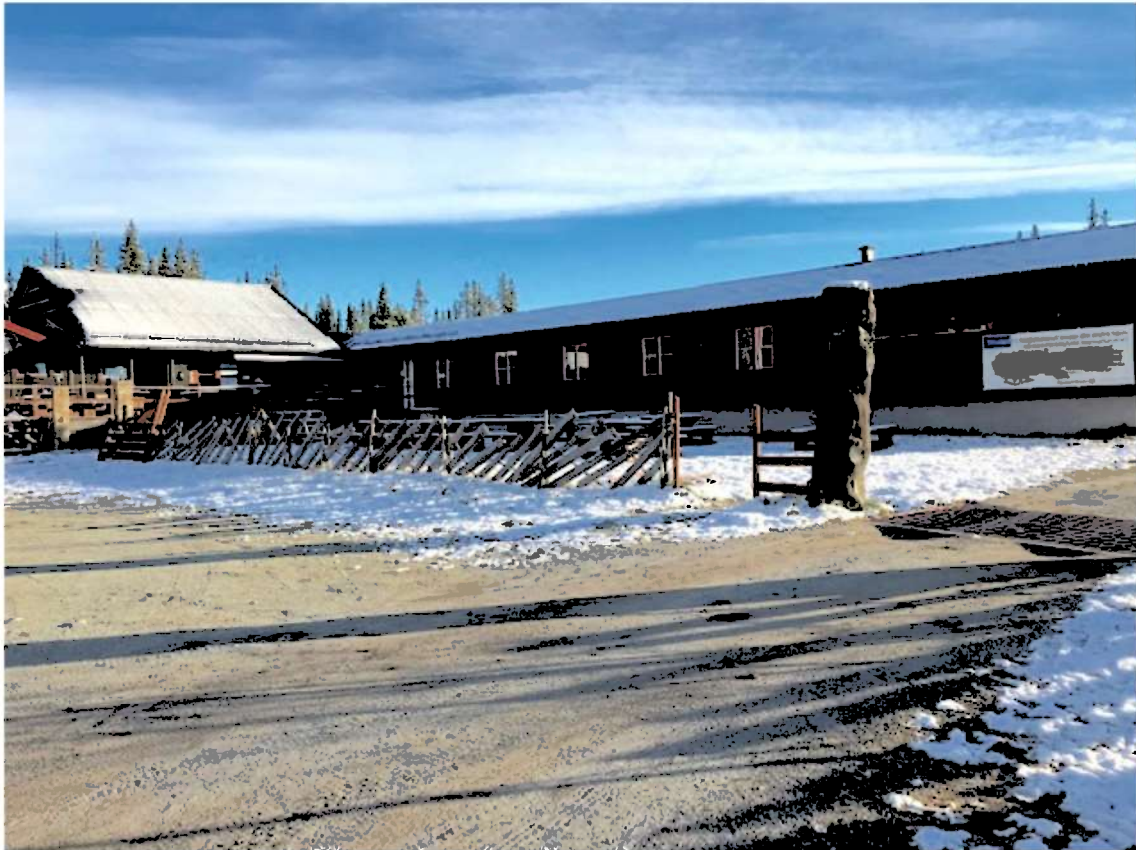
Ill 27: I denne delen av Haglebu Fjellstue planlegges påbygget ca 10 utleierom i ny 2. etasje.
