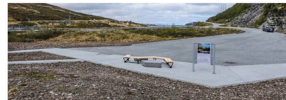
Overgang mellom asfalt grus og betong
