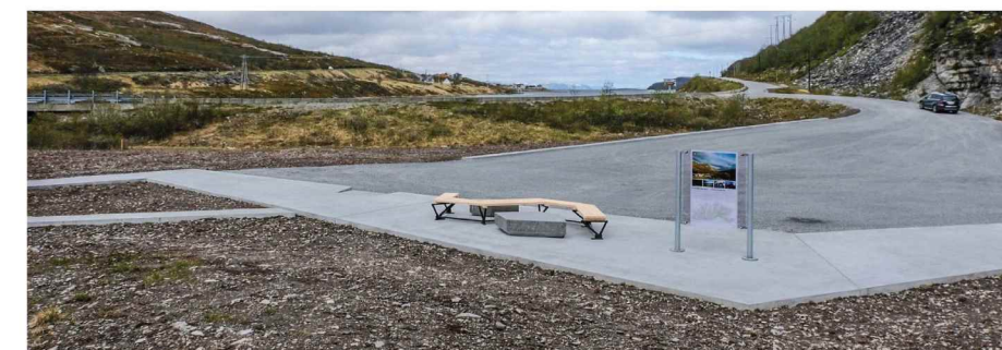
Overgang mellom asfalt grus og betong
