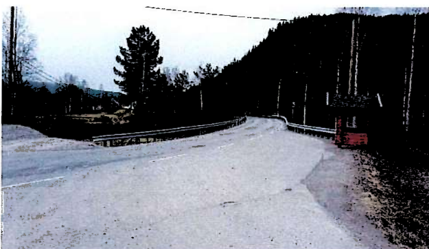
Kryss ved fylkesvei retning sør.
