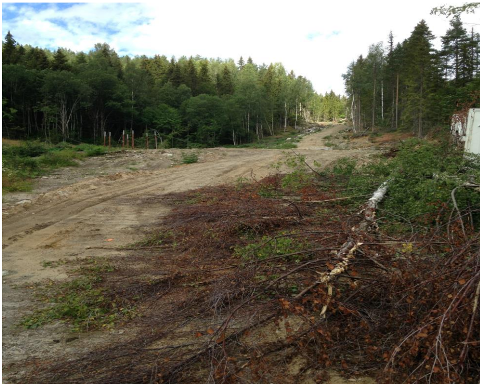
Skogsveg/ midlertidig anleggsveg bak/vest for steinbrudd/ masseuttak
