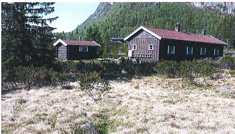
Eksisterende hytte og anneks, bilde er tatt fra parkeringsplassen.
