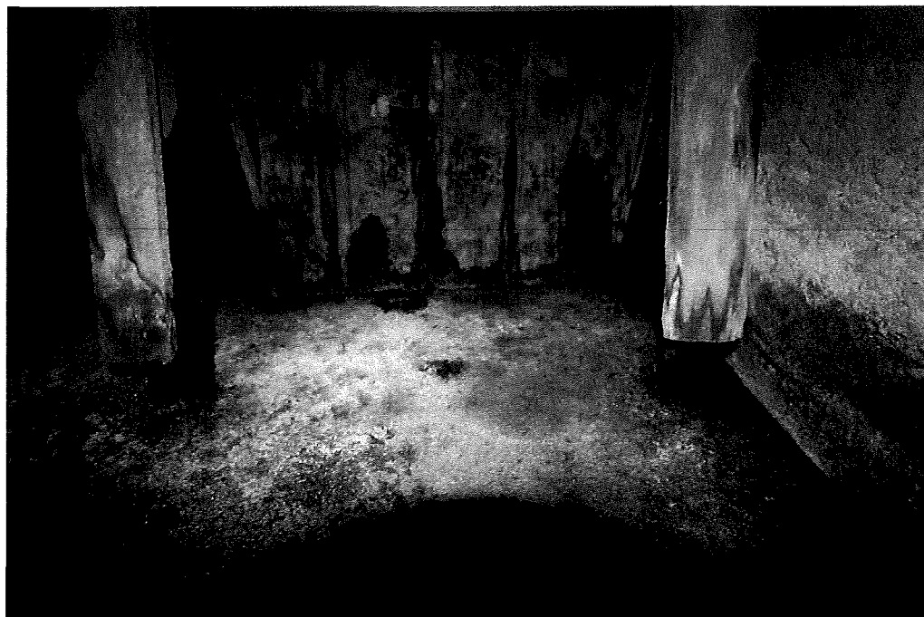
Eksempel fra fukt i kjeller.
