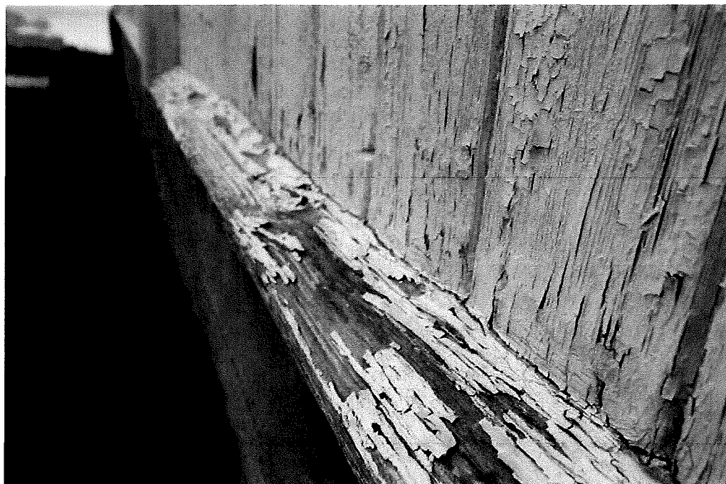
Keldning og vannbrett utv.
