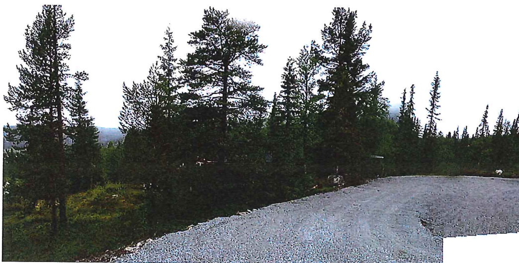
Figur 9. Eksisterende snuplass ved eksisterende fritidsbolig gnr 141 bnr 38. Fotostandpunkt F sett nordover.
