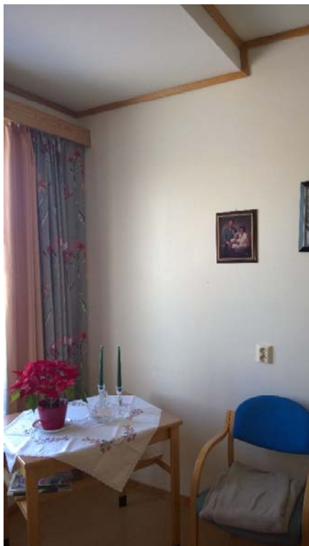
Bilde 6 Utvidelsen på beboerrom er kledd med 1 lag 13 mm gips som ikke tilfredsstillende kravene til brannmotstand EI60.
