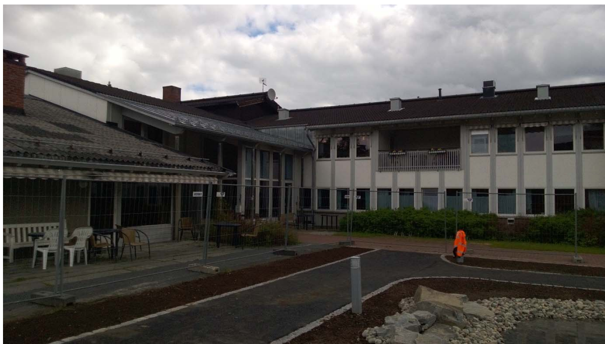
Bilde 12 Vinduer i innvendig hjørne har ikke brannmotstand.
