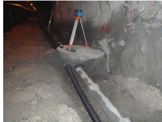
Drenasjesystem i Horgatunnelen, januar 2013
