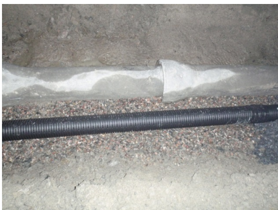
Drenasjesystem i Horgatunnelen, januar 2013
