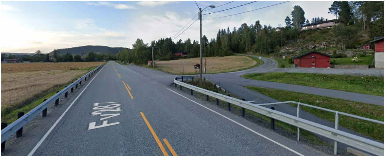
FIGUR 38: AVKJØRING FRA SIGDALSVEIEN (FV.287) TIL SKATVEDTVEIEN
