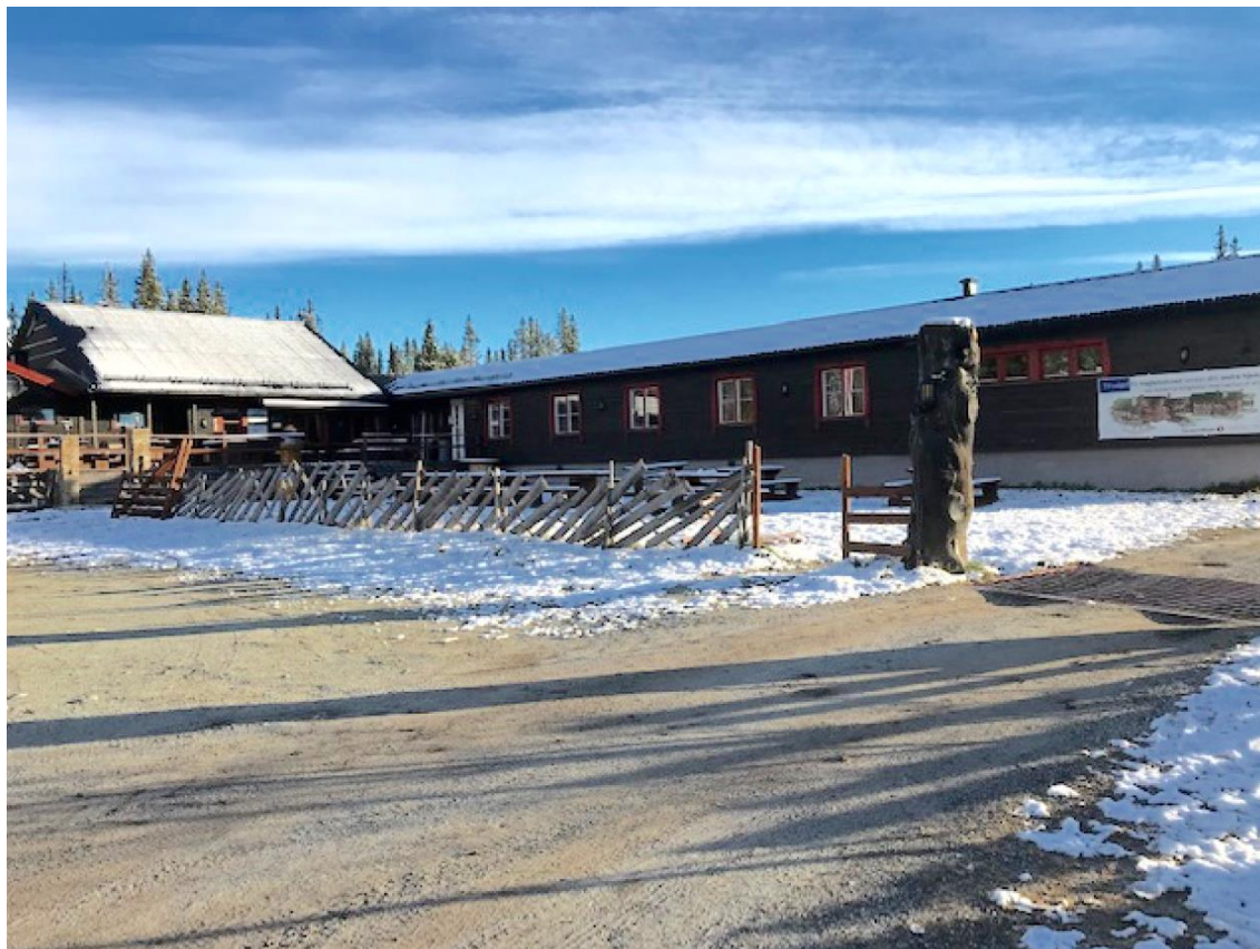
Ill 27: I denne delen av Haglebu Fjellstue planlegges påbygget ca 10 utleierom i ny 2. etasje.
