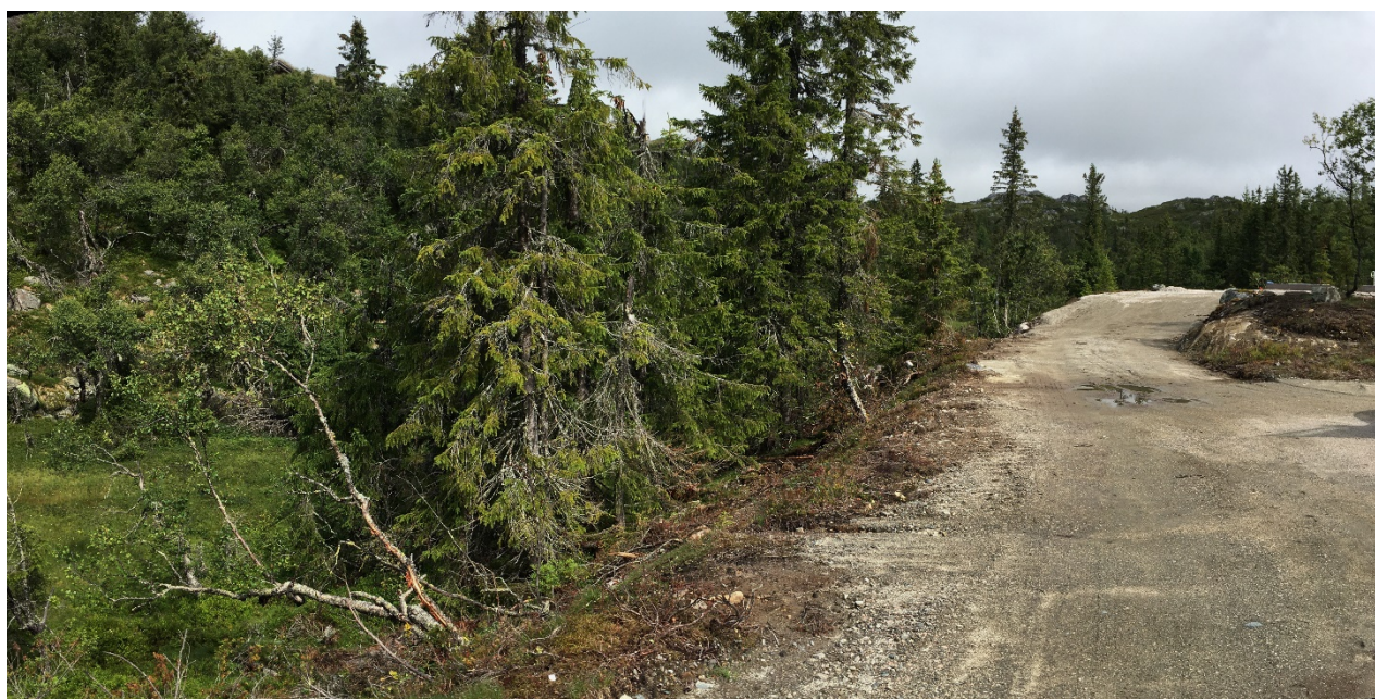
Foto fra veg til tomtene 21,22 og 23. Veg i bildet er til tomt 2x, og ny adkomstveg er lagt ned til venstre i bildet, krysser over myra og følger kanten videre innover på vestsida av daldraget.
