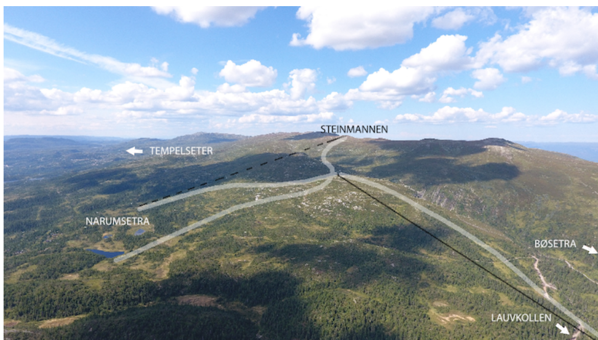
FOTO: DRONEFOTO. LINJENE VISER SKJEMATISK Plassering AV HEISER OG NEDFARTER. STIPILET SVART LINJE ER TUNELLBANE FRA NARUMSETRA TIL STEINMANNEN. HELTRUKKET SVART LINJE ER HEIS FRA LAUVKOLLEN. HVITE LINJER VISER FORESLÅTTE NEDFARTER.
