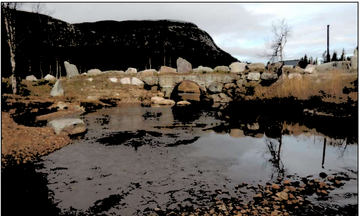
Figur 4: Bru/kulvert over Flenta ved tilkomstveg til planområdet.
