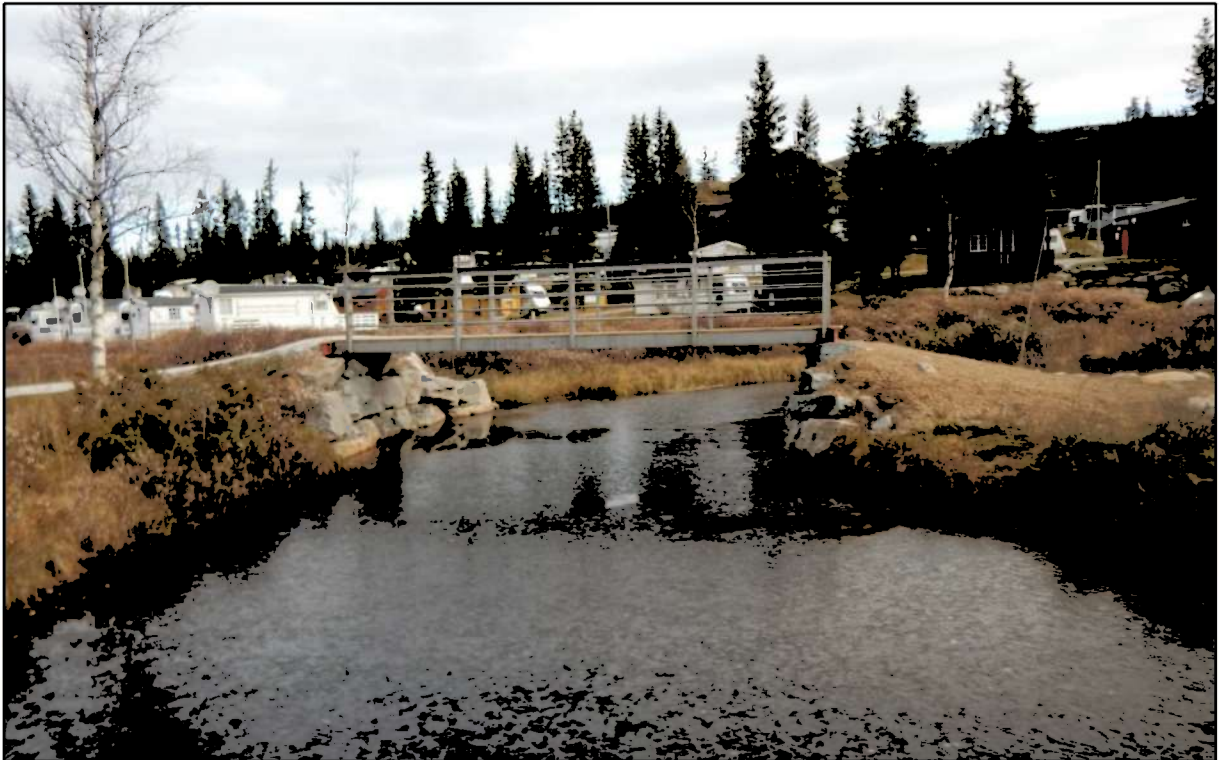
Figur 3: Bru over Flenta ved ny gangvei.
