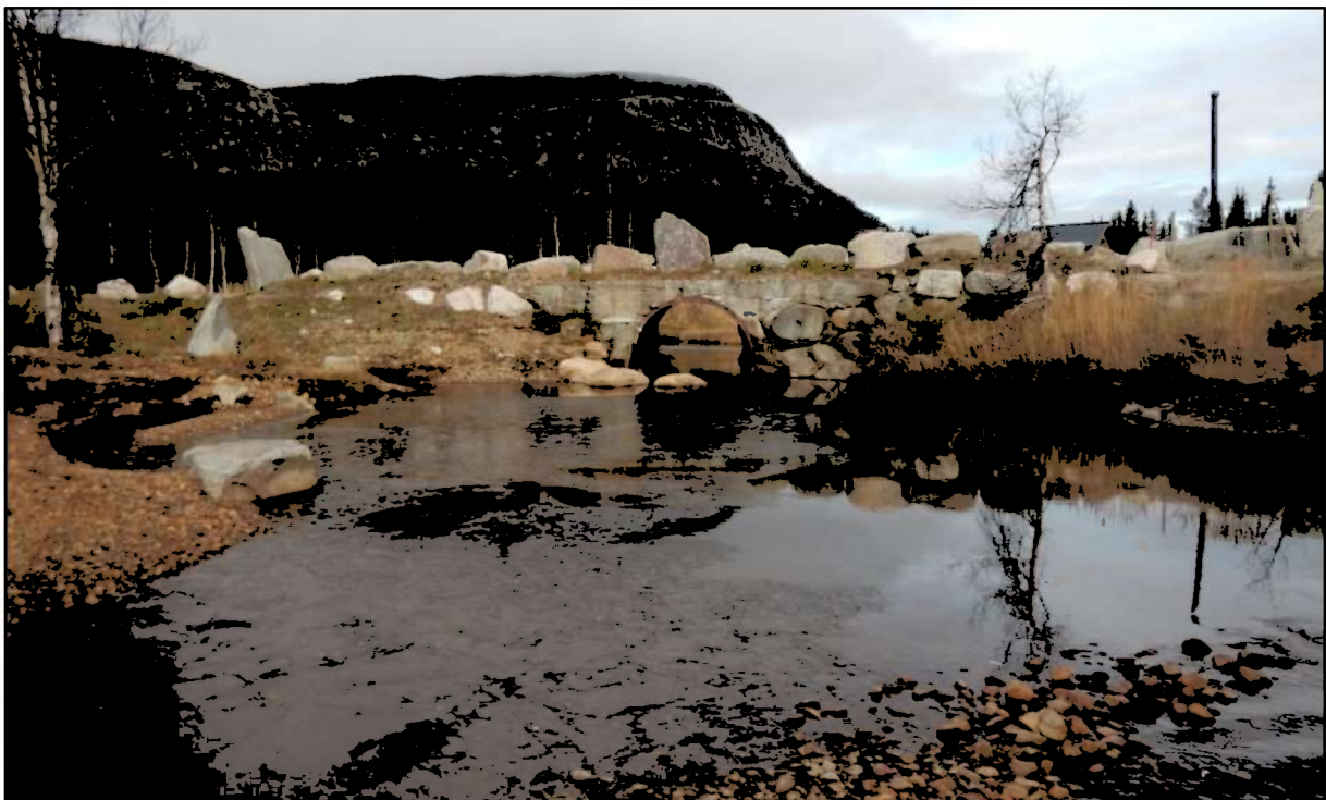
Figur 4: Bru/kulvert over Flenta ved tilkomstveg til planområdet.
