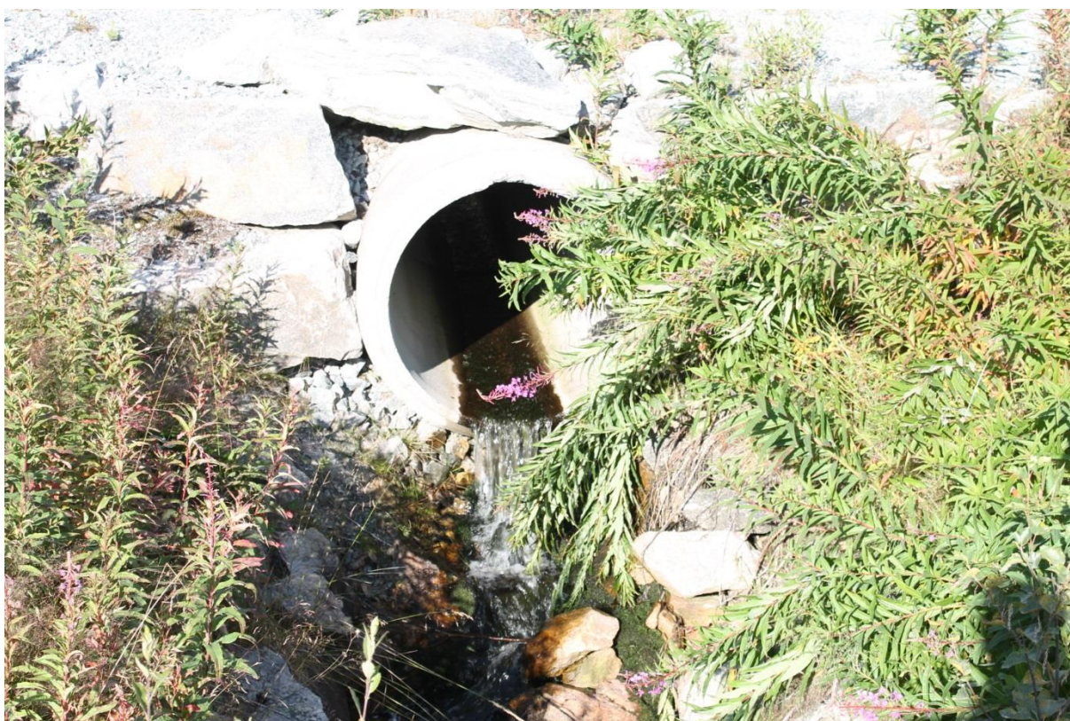
Hyttebekk ved kulvert under Djupsjøveien, august 2016.
