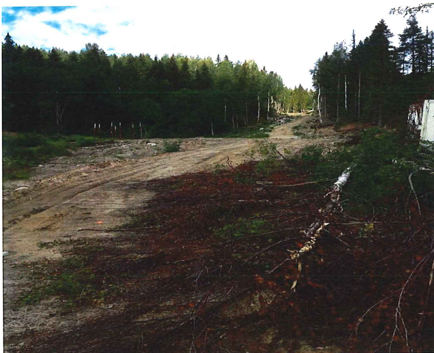
Skogsveg/ midlertidig anleggsveg bak/vest for steinbrudd/ masseuttak
