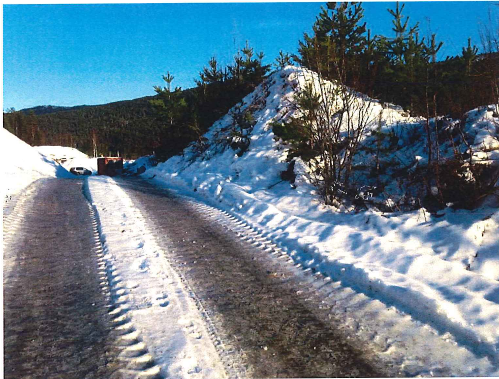
Opparbeida jordvoll/ støyvoll mellom Fv.287 og masselager
